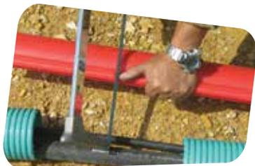
3. Corte 3 cm del ensamble mecánico a los extremos de la sección de reparaducto
