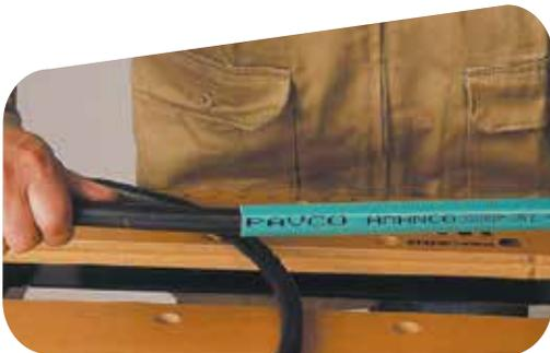
2. Caliente directamente con un solpete, asegurándose que la parte "azul" de la llama no entre en contacto con la tubería.
