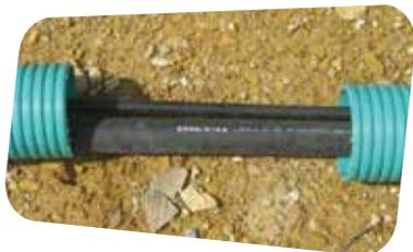
2. Corte el tramo de reparaducto para la sección dañada
