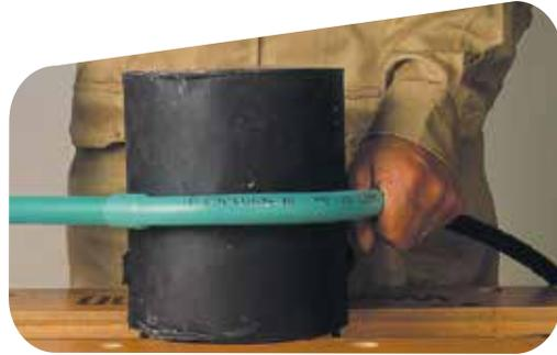
4. Tensionar el tubo a medida que se dobla para evitar arrugas en la parte interior de la curva.
