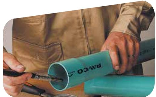
6. Una el tubo con el accesorio asegurándose de un buen asentamiento, gírelo un cuarto de vuelta para distribuir la soldadura y mantenga firmemente la unión por 30 segundos.
