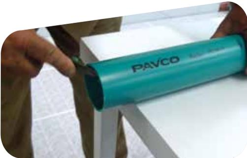
3. Limpie bien las superficies que se van a conectar tanto del tubo como del accesorio, con un trapo limpio humedecido en Limpiador Removedor PAVCO.
